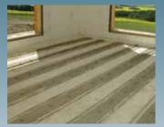
TRUSS FORMS CAN BE POURED INDEPENDENT OF SLAB OR AS A MONOLITHIC SYSTEM.
